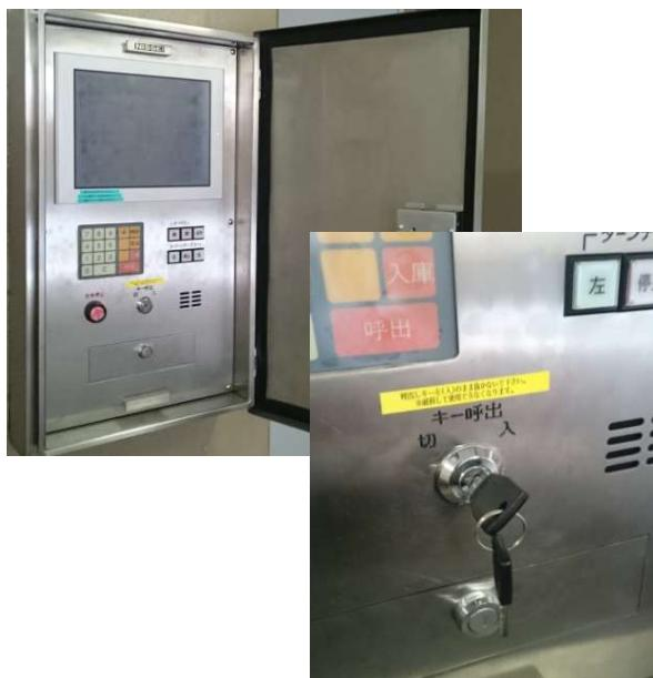
①操作盤を開けて、鍵を差し込み「入」に回します。
