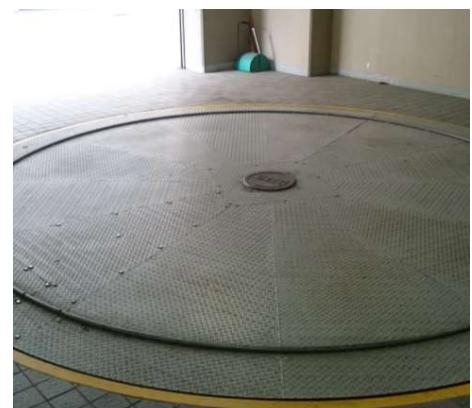
出庫時はターンテーブルまでバックして頂き、出庫しやすい位置に調整してください。右が右回り、左が左回りに回転します。180度回り自動で停止します。※停止ボタンでも止めることができます。
